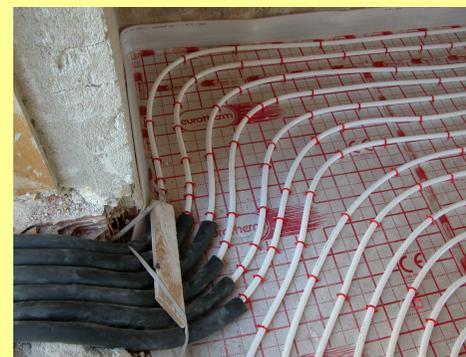
Il sistema di riscaldamento di questa struttura è alimentato dall'energia solare integrata con una caldaia a biomassa e da una caldaia a condensazione. L'impianto di riscaldamento è a pavimento, costituito da tubi in polietilene reticolato ad alta densità, in cui circola acqua calda ad una temperatura massima di 45°.
