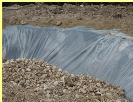
La realizzazione di un impianto di fitodepurazione consente la depurazione naturale delle acque di scarico della struttura attraverso il filtraggio della ghiaia e l'azione delle piante. Questo impianto di fitodepurazione è della tipologia **"a flusso subsuperficiale orizzontale"**, il liquido di scarico non è mai all'aria aperta e il substrato è sempre saturo.
